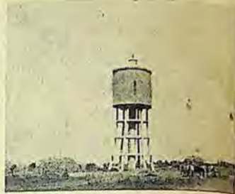
Резервуарътъ на помпената станция въ с. Щръклево
