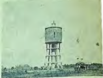
Резервуарътъ на помпената станция въ с. Щръклево
