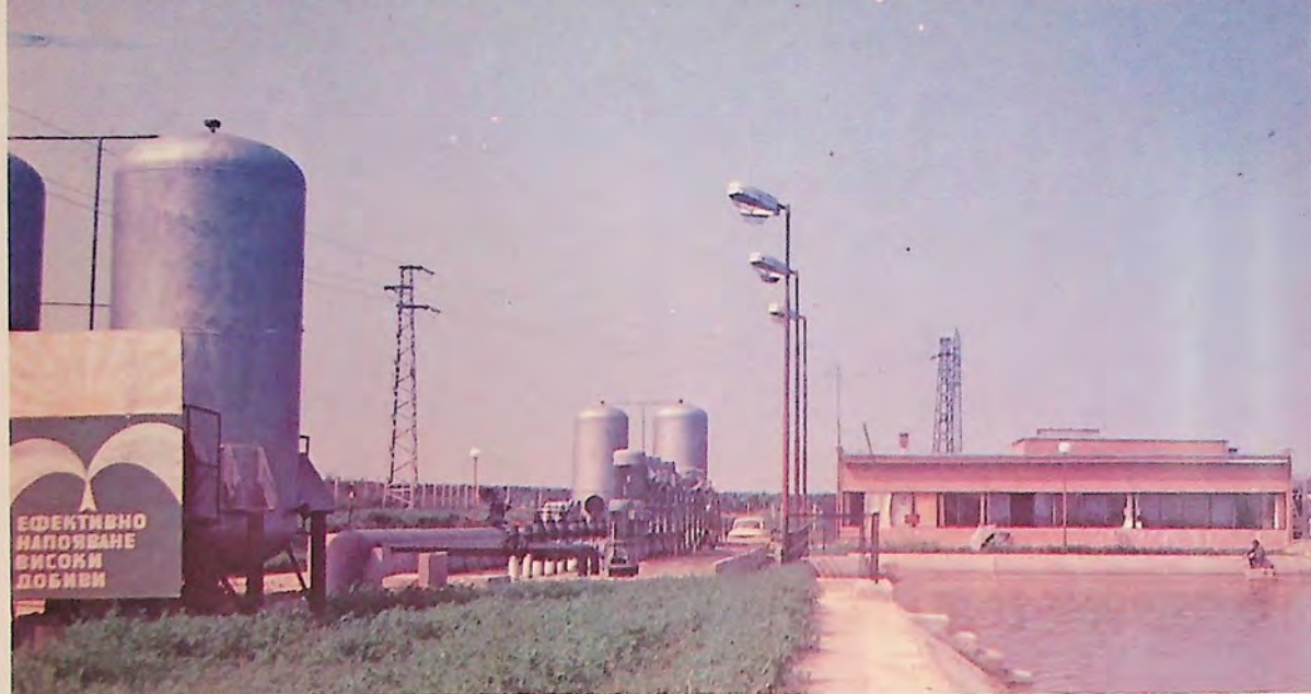
Помпена станция „Бъзън“
