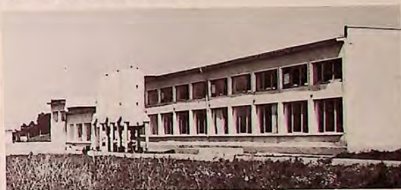
Помпена станция „Антимово 2“
