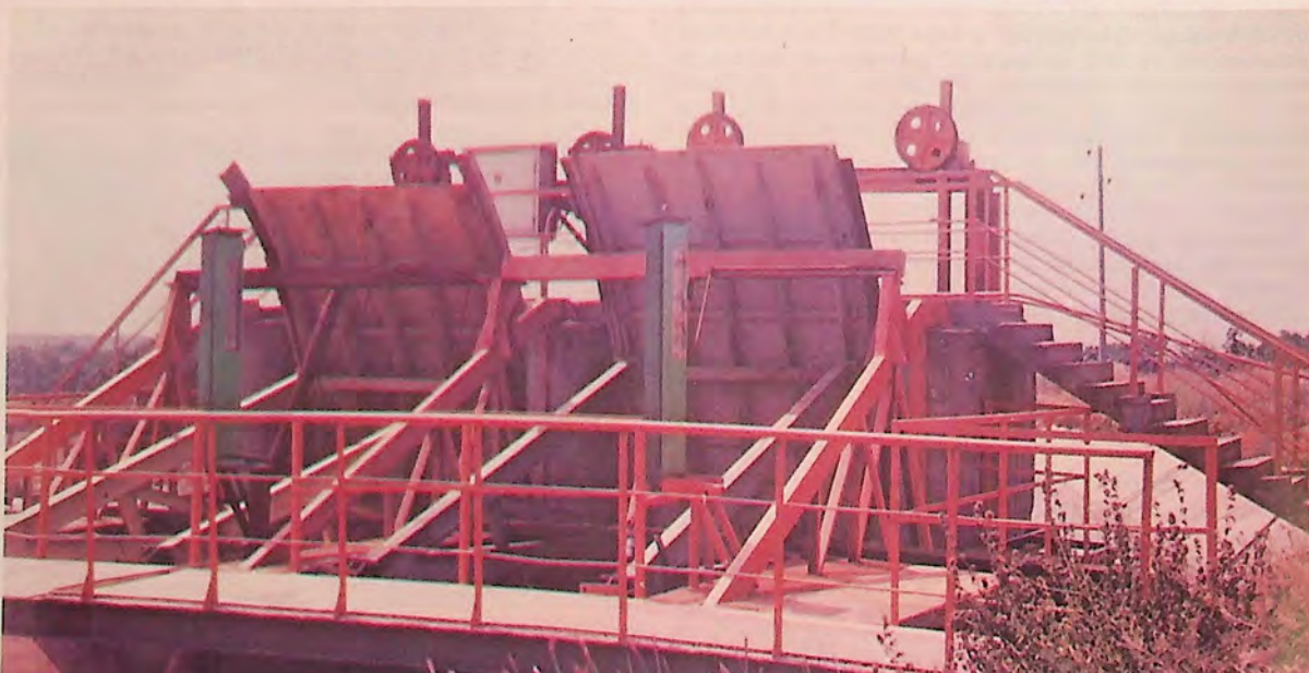
Сегментни затвори на канал М-0
