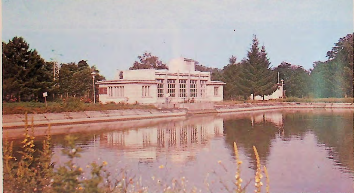
Помпена станция „Тръстеник“
