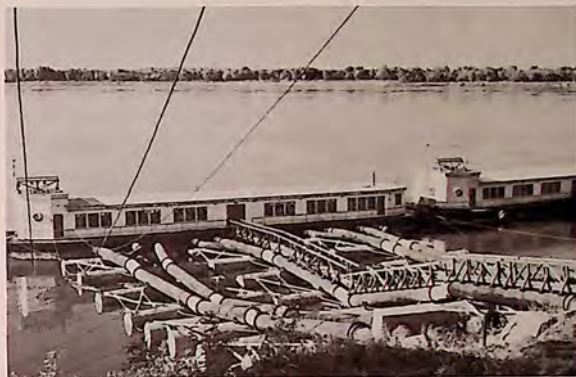
Плаваща помпена станция № 23 на р. Дунав
