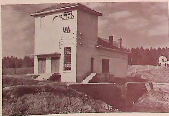
Трета отводнителна помпена станция край Тутракан
