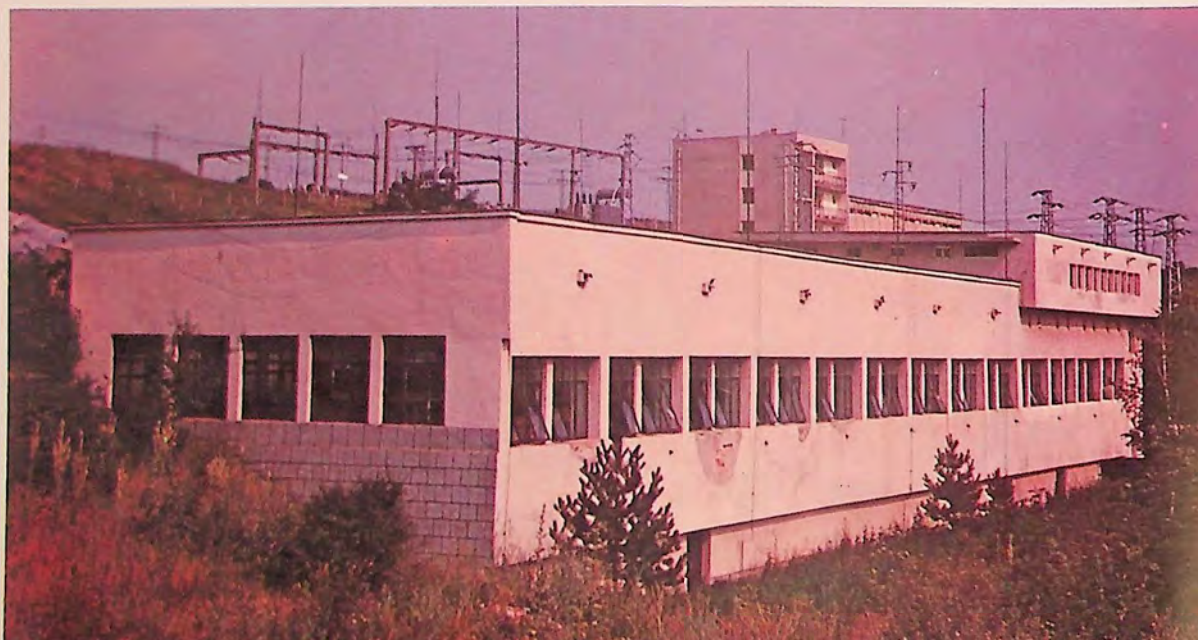
Помпена станция „Красен“
