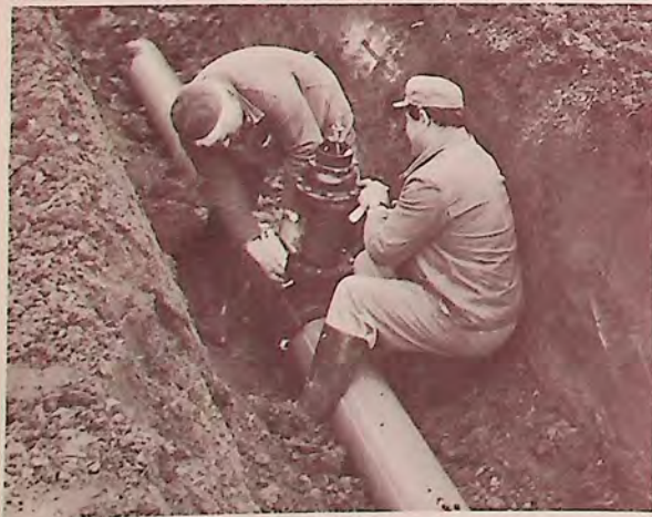
Изграждане на тръбопровод от PVC—тръби
