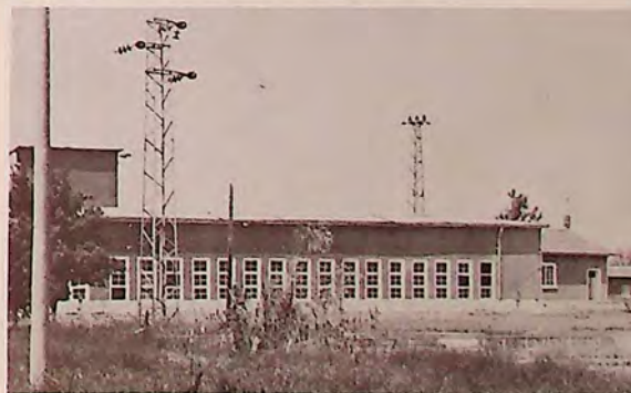
Отводнителна помпена станция „Бръшлен II–А“
