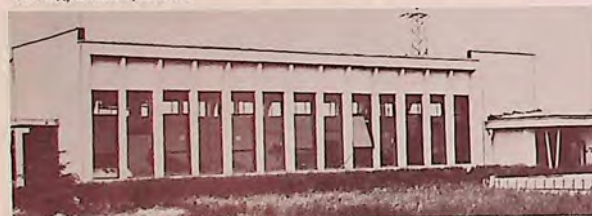
Помпена станция „Тутракан 2“
