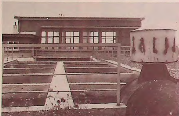
Помпена станция „Долапи 2“
