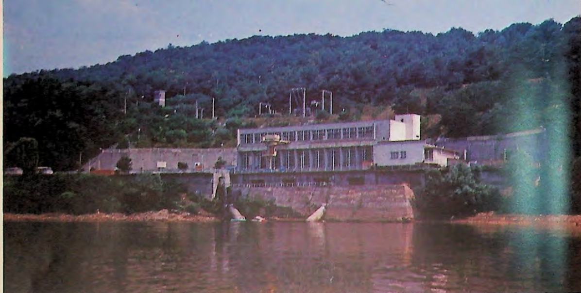
Помпена станция „Люляка“
