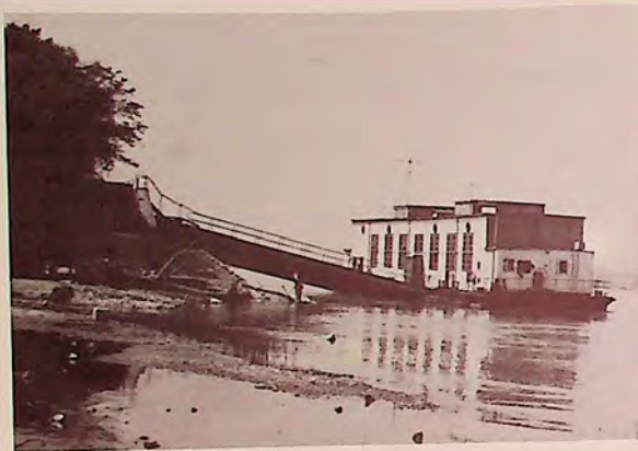
Плаваща помпена станция „Мартен 20“ на р. Дунав
