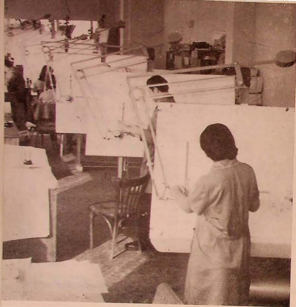
Отдел „Механизация и автоматизация на производствените процеси“ — конструктивна зала
