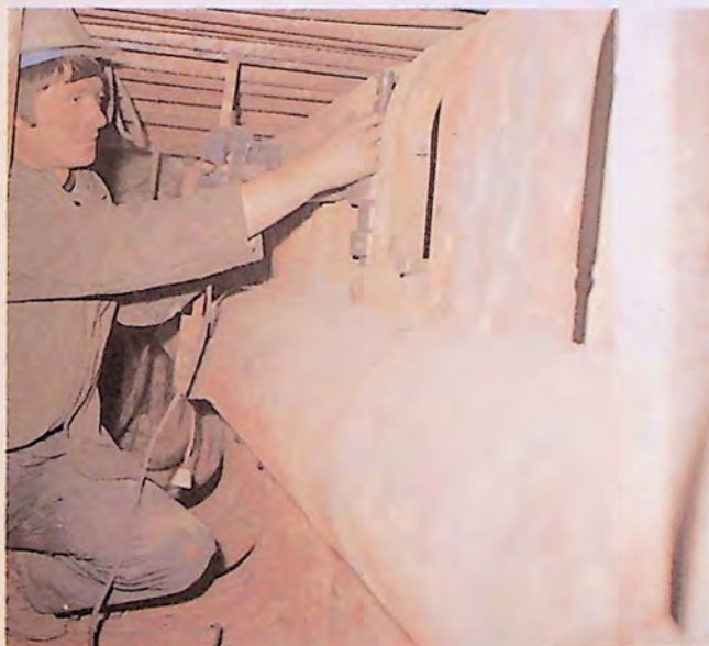
Ремонт на нагревни повърхности Ремонт поверхностей нагрева Repair of heating surfaces
