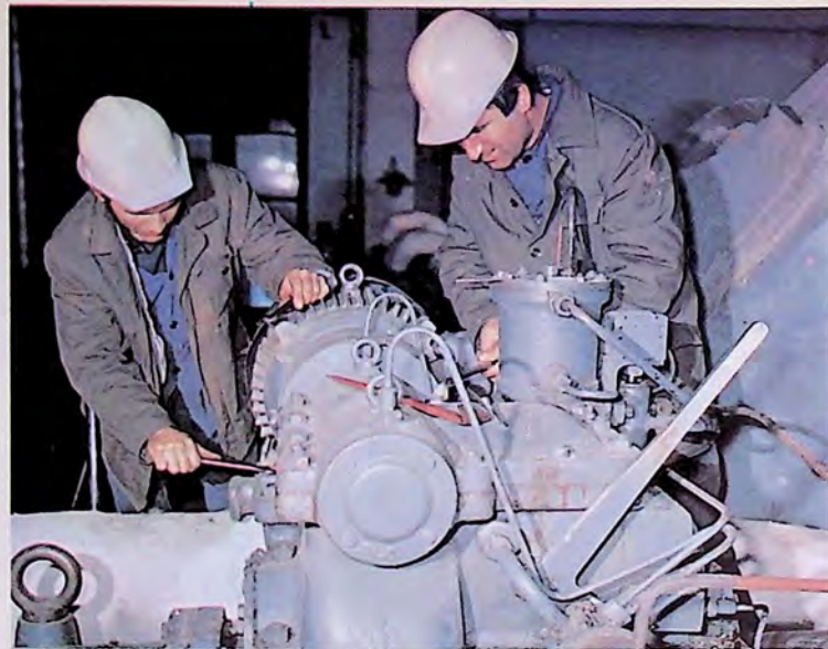
Ремонт на турбинно оборудване Ремонт оборудования для турбин Repair of turbine equipment
