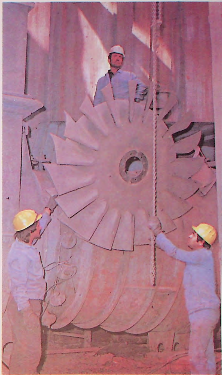
Ремонт на въздушни вентилатори Ремонт воздушных вентиляторов Repair of air fans
