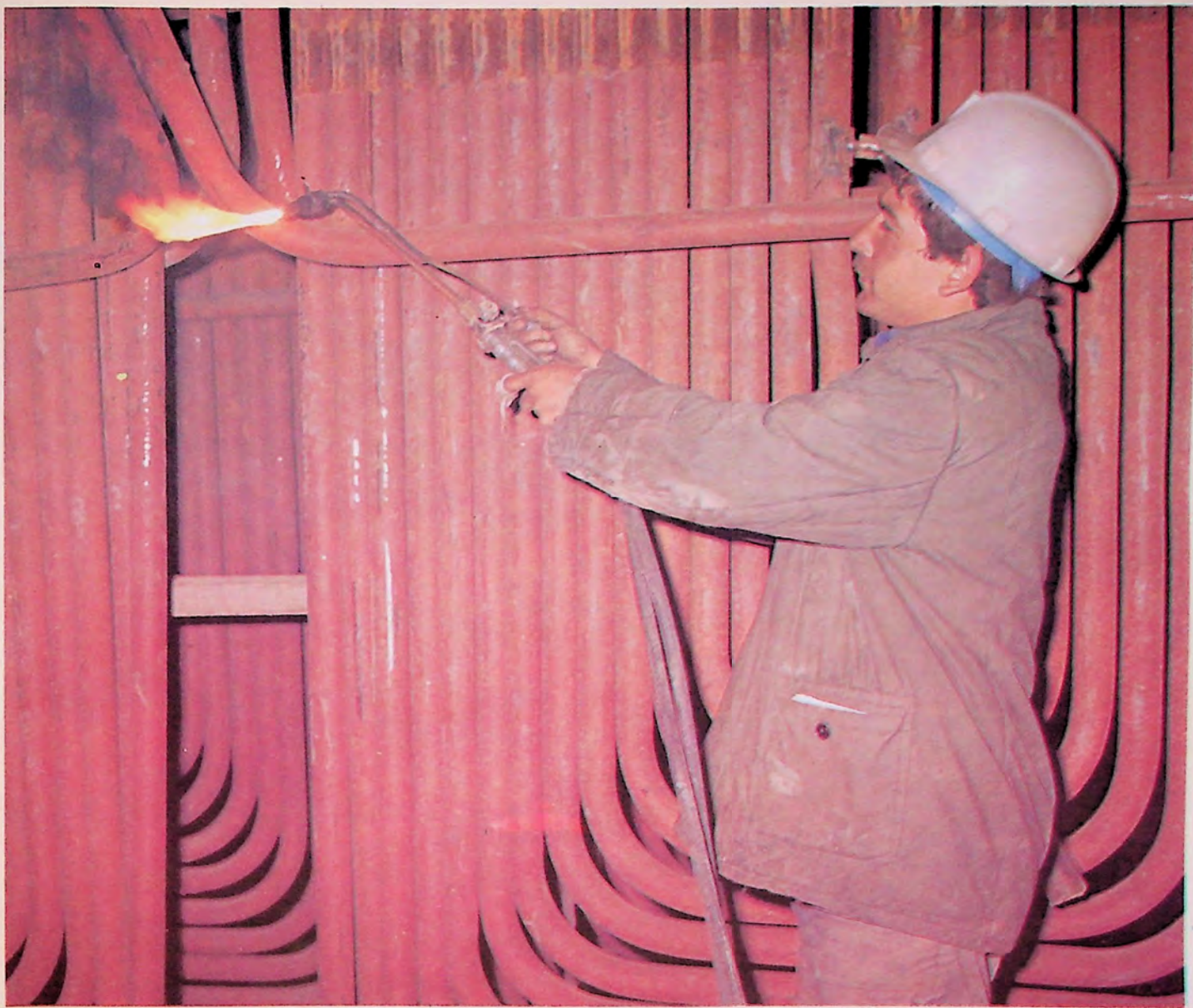
Подмяна на ширмов паропрегревател Замена экранного паронагревателя Change of screen superheater
