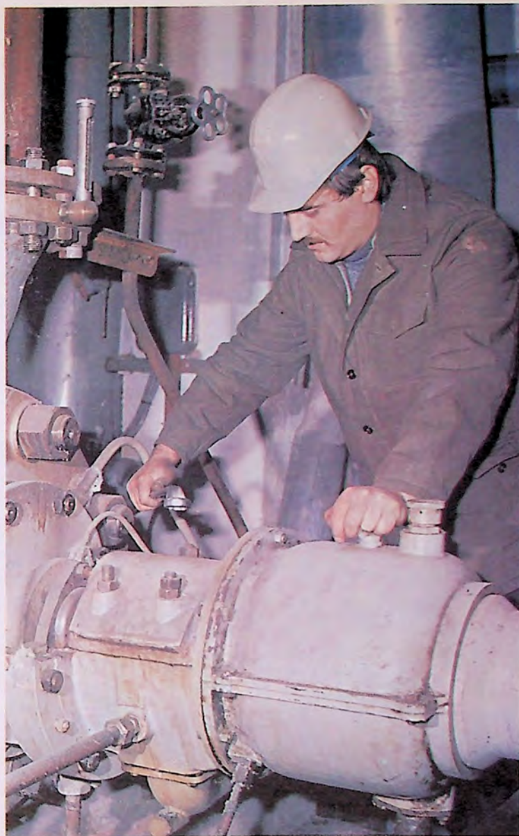
Прецизен ремонт на помпи Надежный ремонт помп Precise repair of pumps
