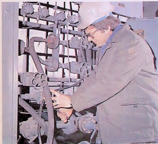
Ремонт на арматура за високо и средно налягане Ремонт арматуры высокого и среднего давления Repair of fittings with high and medium pressure
