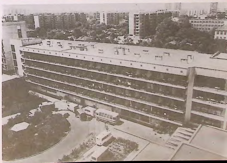
Едроплощен кофраж Крупномасштабная опалубка
