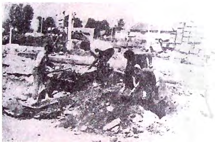
Бригада при изграждането на завода
