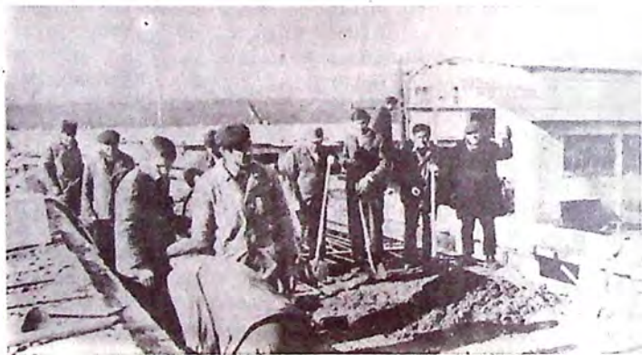
Бригада при изграждането на завода
