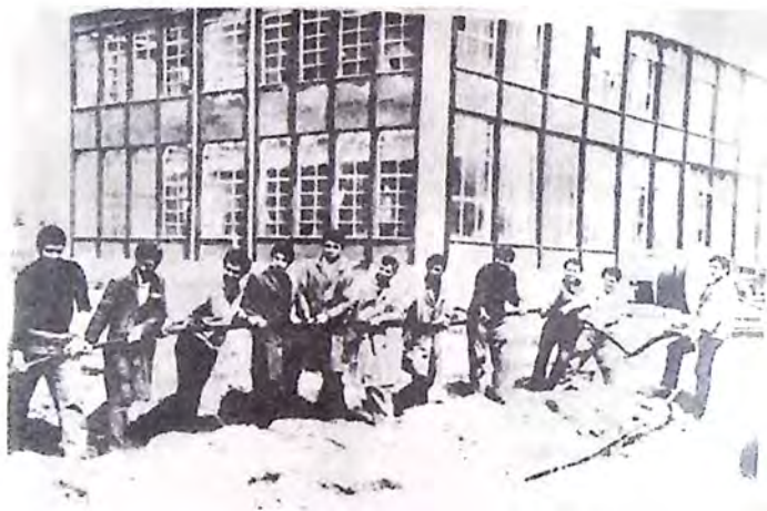
Бригада при изграждането на завода
