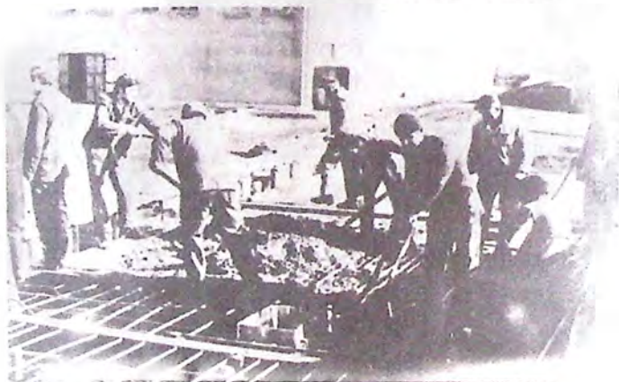
Бригада за изграждането на завода
