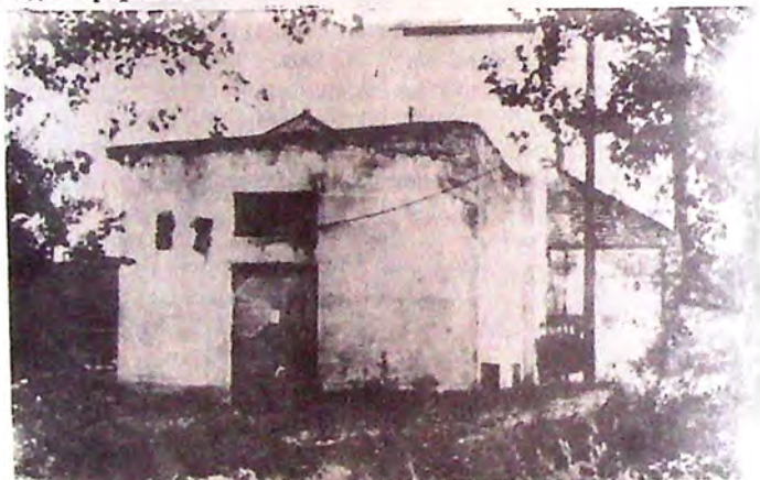
Първият трафопост в Каучуковия цех
